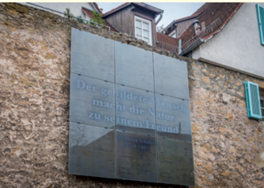
Denkmalgeschützte Stadtmauer mit Dünnschicht-Photo- voltaikanlage
