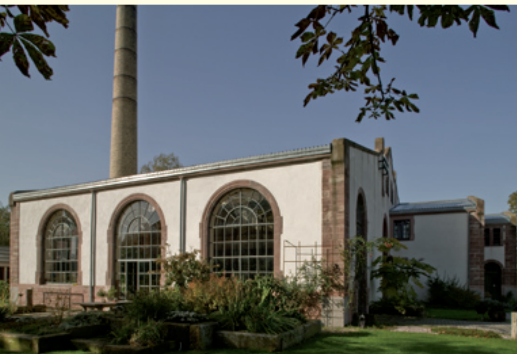
Südostfassade mit Metallrundbogenfenstern und Sandsteineinfassungen
