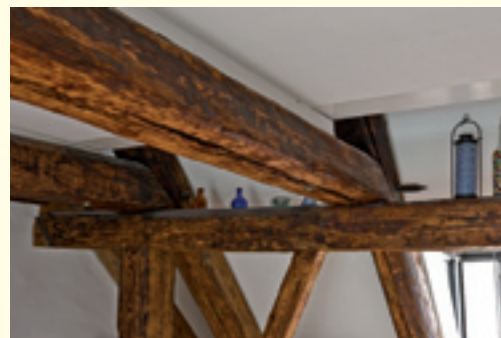
Ausgebautes Dachgeschoss mit mittelalterlichem Dachstuhl
