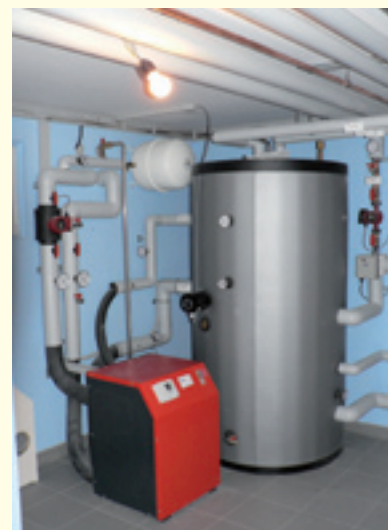
Wärmepumpe und Warmwasserspeicher für ein Wohnhaus
