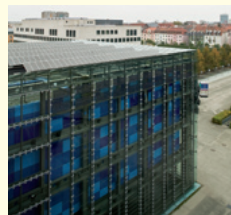
1 Blick in den zum Foyer umgestalteten Lichthof 3 Semitransparente Photovoltaikanlage in den Glasflächen der Hofüberdachung
