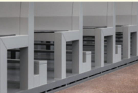
Die Warmluft wird unter das Bankpodest geführt und von dort in die Gänge ausgeblasen
