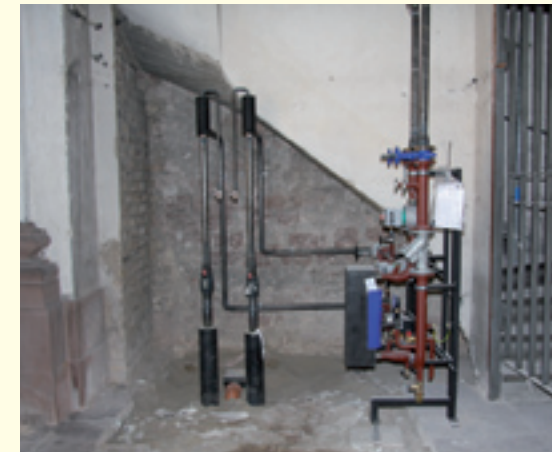
4 Fernwärmeübergabe unter der Empore
