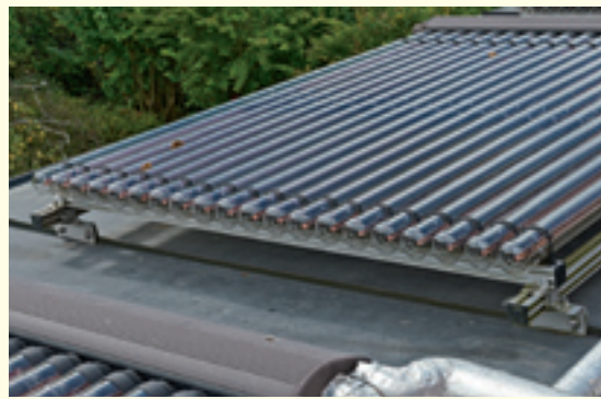
Vakuümrohrenkollektor
