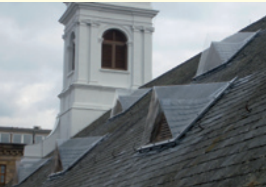
Luftkollektoren über den Dreiecksgauben der Süddachfläche
