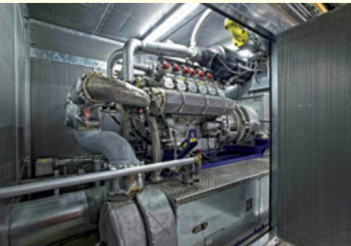
Blockheizkraftwerk des Landeskriminalamts Baden-Württemberg in seiner Einhausung
