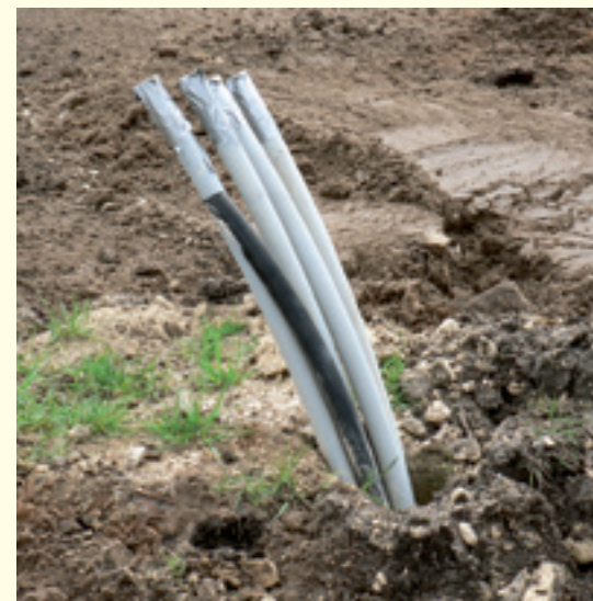
Erdwärmesonde
