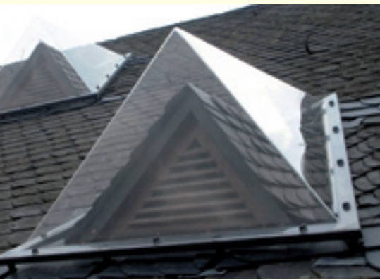
Luftkollektoren über den Dreiecksgauben der Süddachfläche
