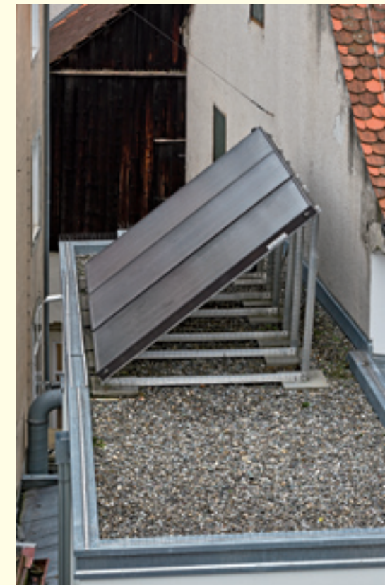
Solarthermischer Flachkollektor
