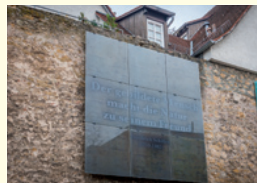
Denkmalgeschützte Stadtmauer mit Dünnschicht-Photovoltaikanlage
