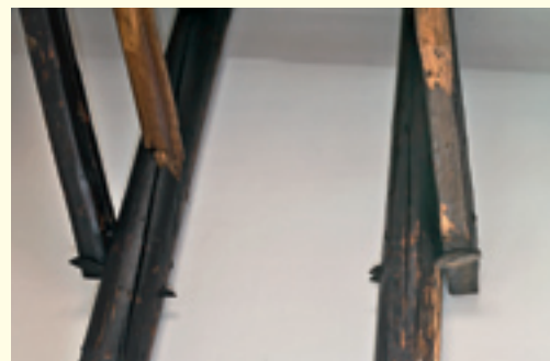
Aufsparrendämmung auf dem verblatteten Dachstuhl
