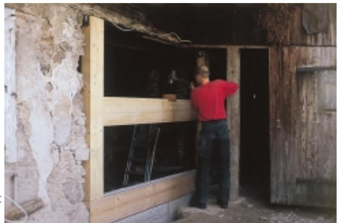
*Die Rauchküche (von oben links): Historische Darstellung einer Rauchküche; Entfernung der Zwischendecke; Einbau des Erschließungsstegs; Rückbau eines massiven Wandteils zugunsten der historisch nachgewiesenen Bohlenwand*
