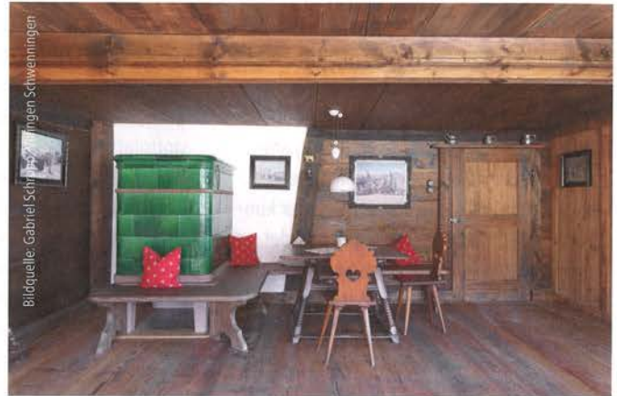
Abb. 12: Der mächtige profilierte Träger, der Sohlbaum, der die Decke der Stube überspannt, ist gut zu erkennen. Der Kachelofen wurde von der dahinterliegenden Küche aus beheizt und war ursprünglich die einzige Wärmequelle des Hauses.
