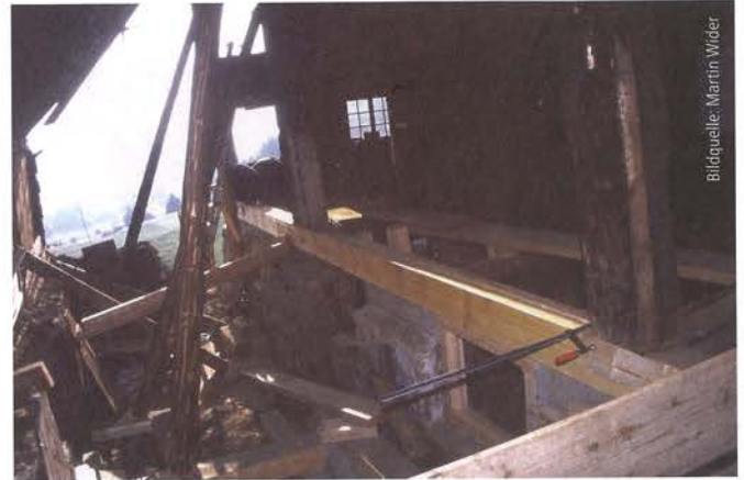
Abb. 9: Blick in den entkernten Anbau, der während der Baumaßnahmen als Wetterschutz diente. Hier ist zudem der Einbau einer neuen Schwelle für die ursprüngliche und zukünftige Außenwand zu sehen.
