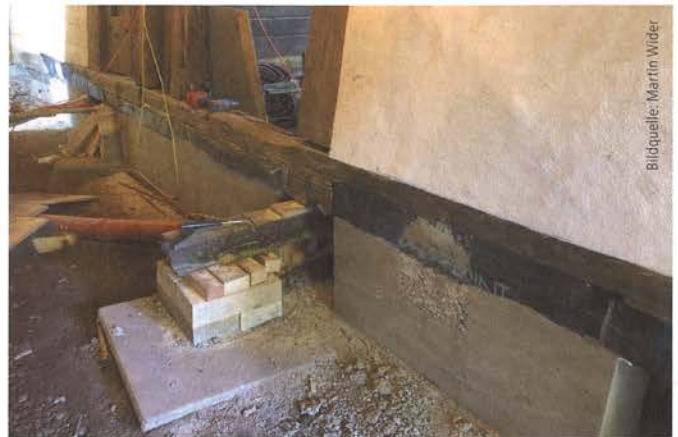
Abb. 12: Hier sind die bereits ausgeschalteten Unterfangungen des Fundaments im Hauseingang zu sehen.
