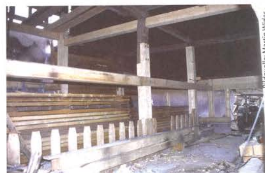
Abb. 6: Blick in den Stall mit dem reparierten Tragwerk. Die neu eingezogenen Geschossriegel und Längsunterzüge komplettieren die klassische Schwarzwaldhofkonstruktion.
