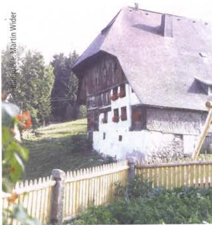
Abb. 8: Blick auf den nördlich angebauten Bereich vor der Sanierungsmaßnahme 1990: Der Anbau hebt sich durch seine geschindelte Fassade deutlich ab.
