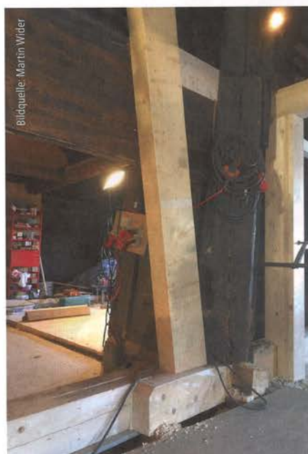
Abb. 4: Zur weiteren Stabilisierung der in Richtung Osten verschobenen Konstruktion wurde eine Strebe eingebaut.
