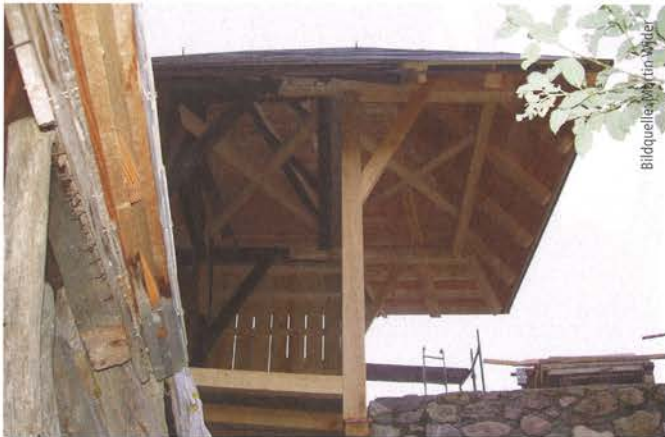
Abb. 11: Der Dachvorsprung der Einfahrt wurde verlängert, um Durchfeuchtungen an der Konstruktion zu verhindern.
