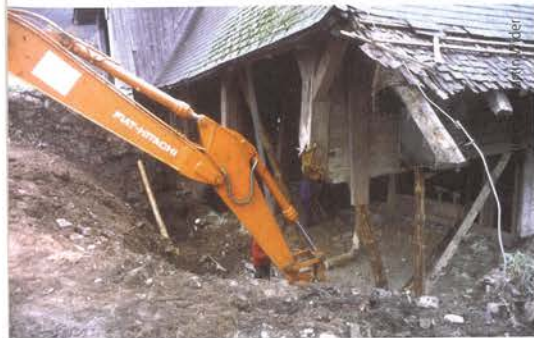
Abb. 4: Die alte Bergmauer musste abschnittsweise abgetragen werden.
