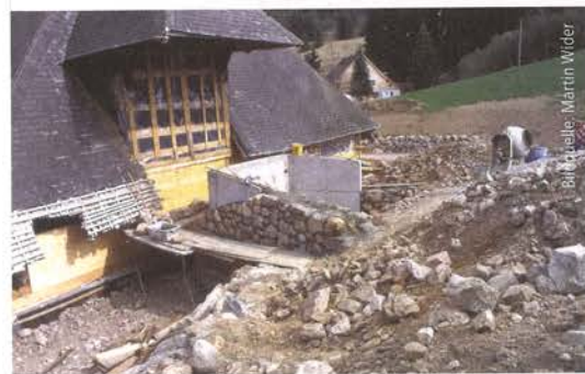
Abb. 5: Die neue Zufahrtsrampe: Der Hangdruck wird heute von dieser Rampe und der neuen, mit den Bodenplatten eingespannten Bergmauer aufgenommen.
