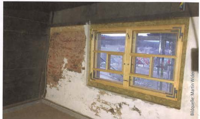
Abb. 7: Eingebaut: die neuen Küchenfenster.
