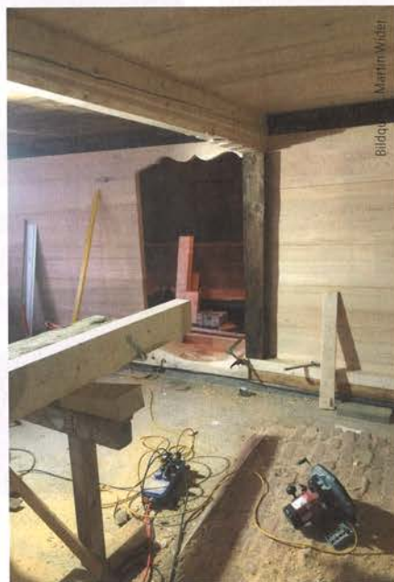
Abb. 5: Nicht mehr vorhandene Wandteile wurden mit neuen Tannenholzdielen ausgefacht.
