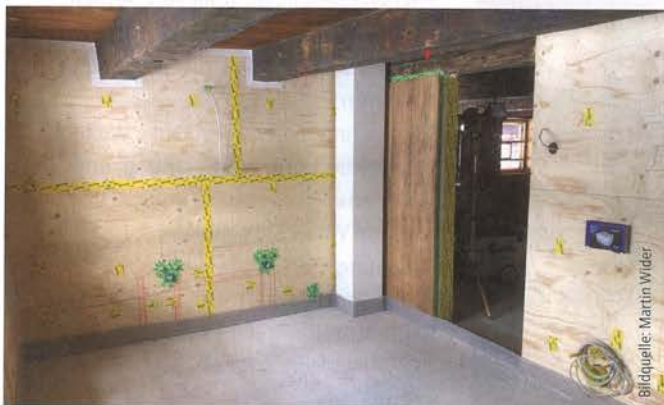
Abb. 8: Die Wände wurden mit Fichtensperrholzplatten winddicht ausgebildet und mit Holzcellulose gedämmt.
