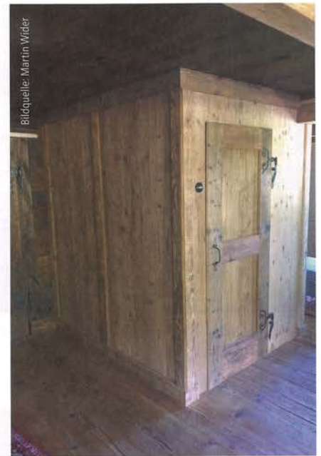
Abb. 10: Die Hebeplattform wurde in den instandgesetzten Stegenkasten eingebaut.
