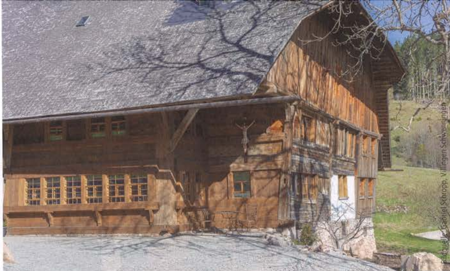
Abb. 3: Die fertiggestellte Südfassade: Das Wechselspiel von Bohlen, Brust- und Sturzriegel im Verbund mit dem Alemannischen Fensterband ist gut zu erkennen.
