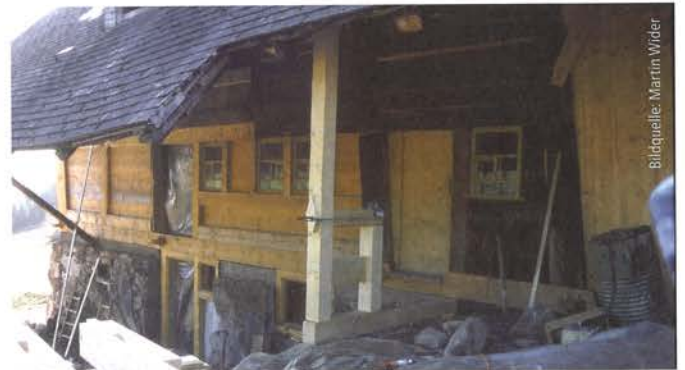
Abb. 10: Die neue, nördliche Außenwand der Altbauernwohnung im Rohbau. Deutlich zu erkennen ist die auch bei Abb. 9 erwähnte Schwelle.
