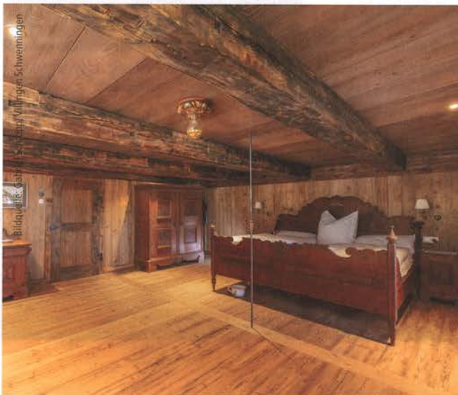
Abb. 13: In der Schlafkammer oberhalb der Stube ist in der Bildmitte die Zugstange zu erkennen, die der Abspannung der Stubendecke dient.
