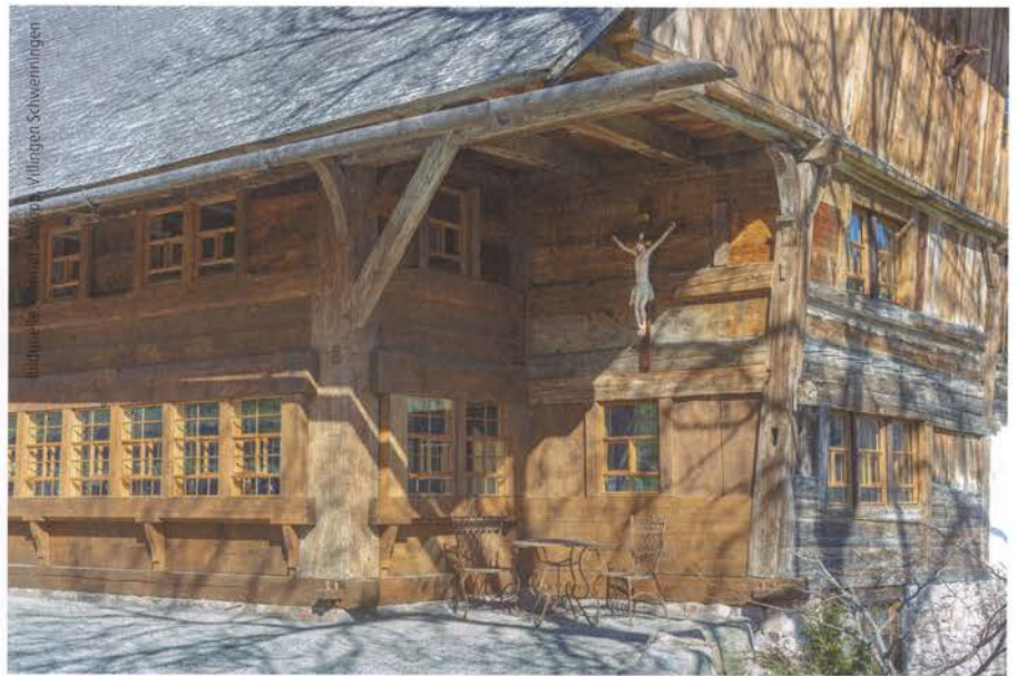
Abb. 2: Für die Schwarzwälder Bauernhäuser war die Bohlenstube als einziger beheizter Raum mit ihrem durchgehenden Fensterband typisch – beim Wildenhof wurde dieses Fensterband gegen Ende der Sanierung wiederhergestellt.
