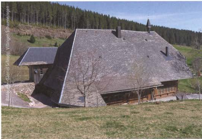
Abb. 17: Die auch beim Wildenhof zum Schutz der Holzkonstruktion tief heruntergezogenen Traufkanten sind ein typisches Merkmal der Schwarzwälder Bauernhäuser.
